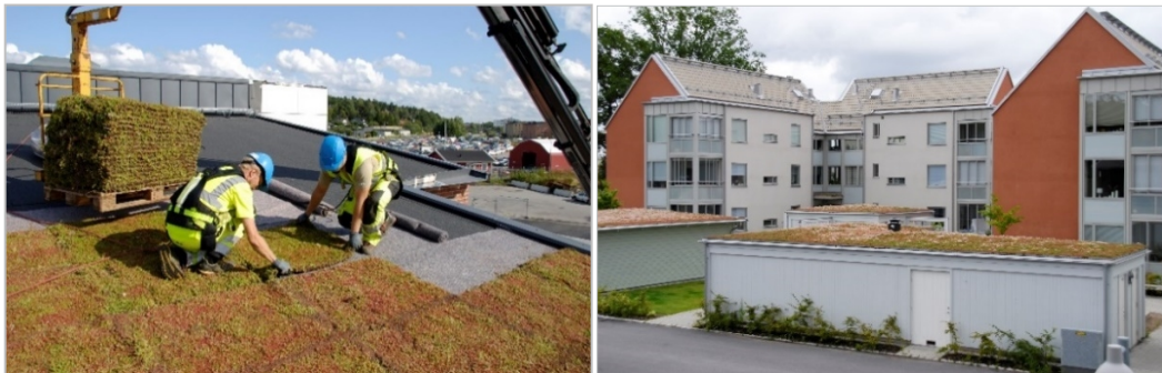
Figur 2. Anläggning av gröna tak till vänster och färdigt tak på miljörum till höger, bilder från vegtech.se.
