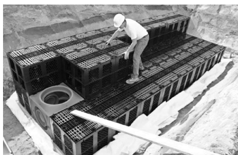
Till vänster dagvattenkassetter och till höger skiss av makadammagasin på fastighet. Bilderna är tagna från tillhörande dagvattenutredning.
